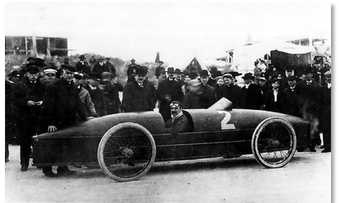
Een heel verschil met de Stanley Rocket uit 1906 die tot eind augustus recordhouder was. Deze 'omgedraaide kano op wielen' had een eigen massa van slechts 760 kg en werd aangedreven door een tweecilinder stoommachine.
